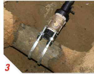
3 Kılavuz matkap boruya değene kadar bağımsız ilerlemeyi çevirin.
